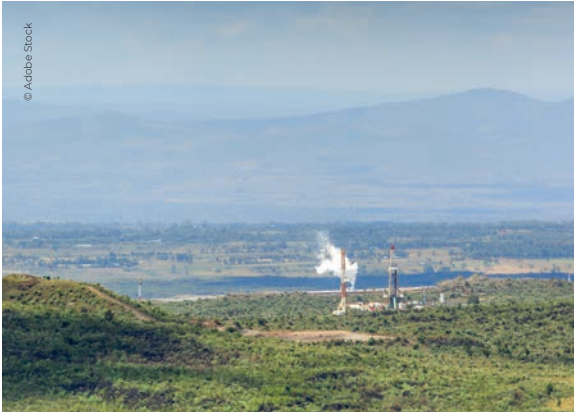
Centrale géothermique dans le cratère de Menengai, Nakuru, Kenya.
